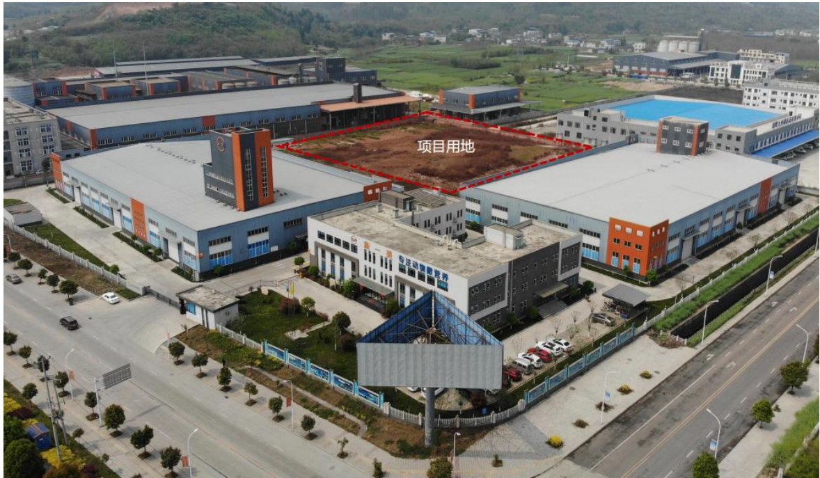
项目开工前场地航拍照
